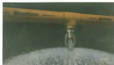
喷头安装示意图
